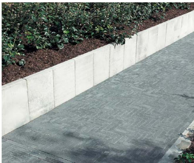
En plus de créer des retenues de terre ou des jardinières, les murets en L permettent également de délimiter une piste cyclable de la chaussée.
